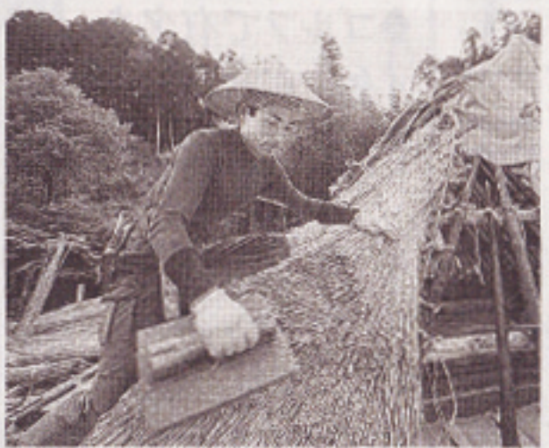
雨粒が軒先へと伝うよう、茅の流れを整える西尾晴夫さん。現場の民家に泊まり込み、雨が降るまで休みはない—兵庫県市川町、荒元忠彦撮影
