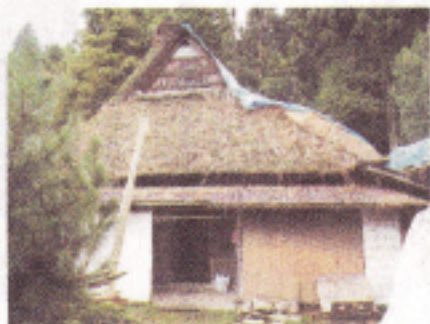
改修作業が進んでいる古民家
