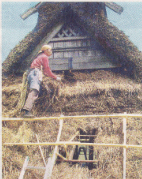
穴の開いたかやぶき屋根を修復する西尾さん(南丹市美山町島Ⅱ)
